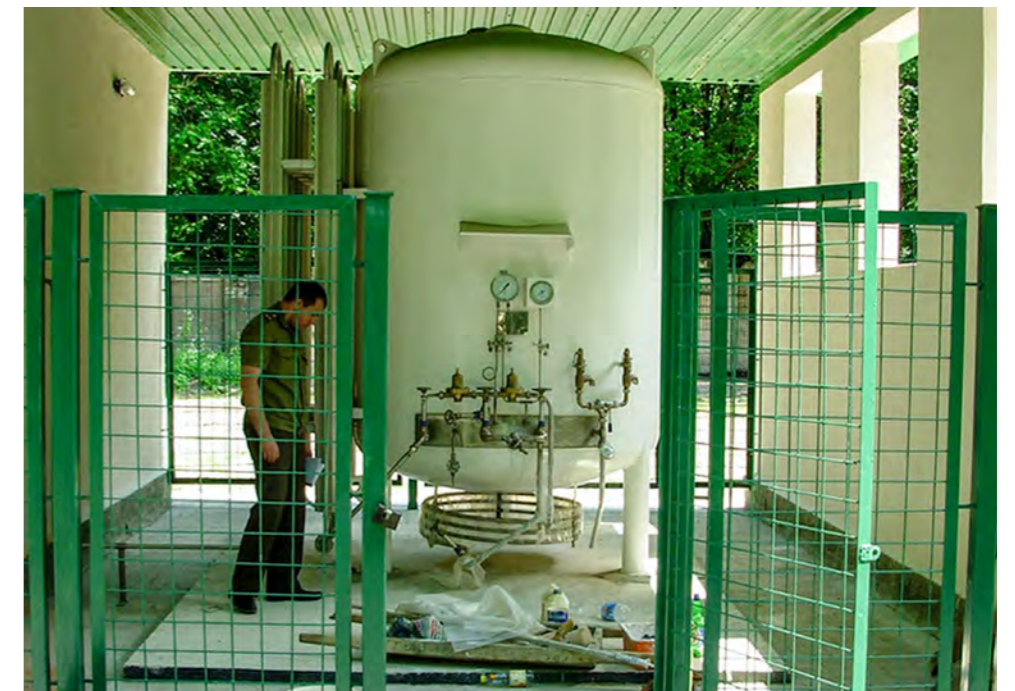
Проверка оборудования, работающего под высоким давлением, 2009 г.
